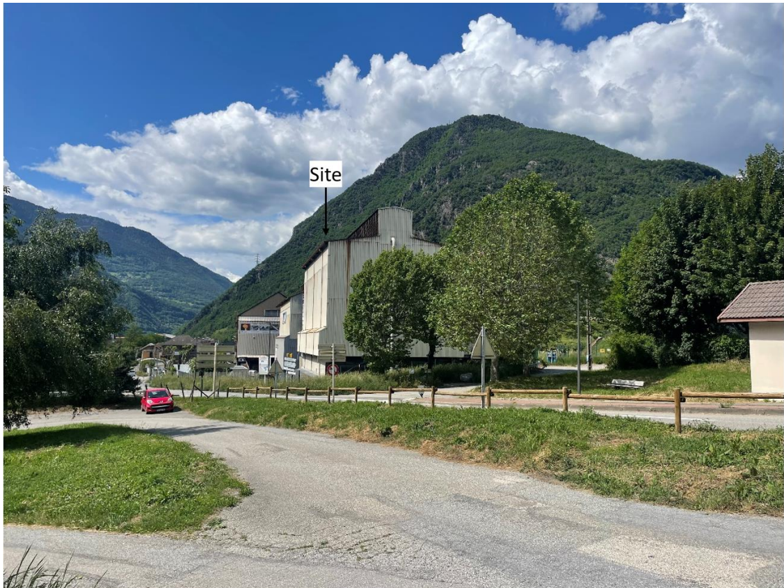
Figure 90 : Visibilité n°5, depuis les habitations au Sud du site (31/05/2023)
